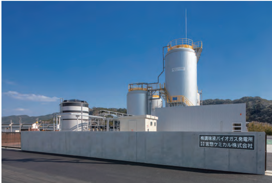
▲上富田町の梅調味液バイオガス発電所
