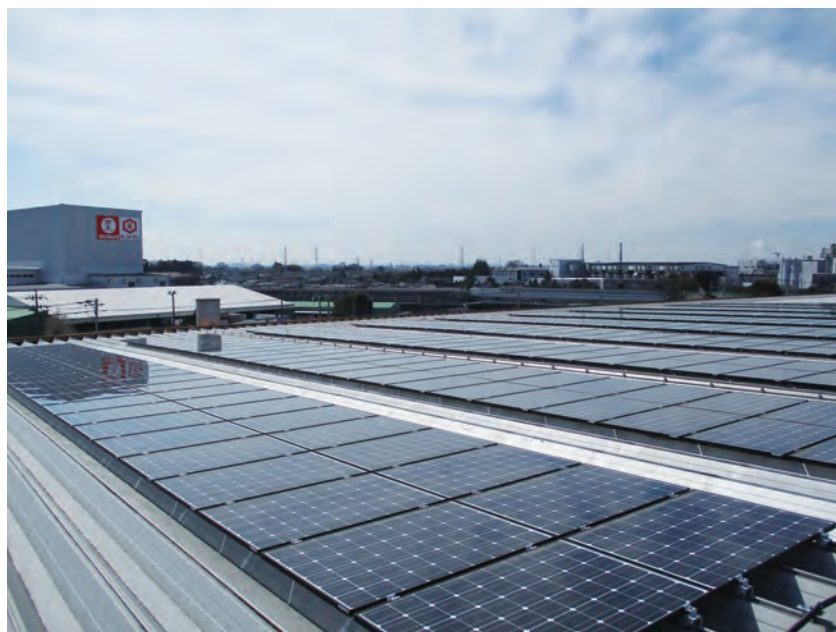
▲屋根に取り付けた太陽光パネル（キッコーマンフードテック）
